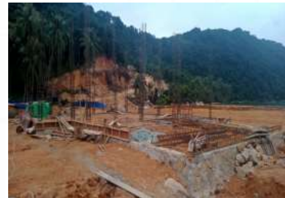
Pekerjaan gedung terminal
