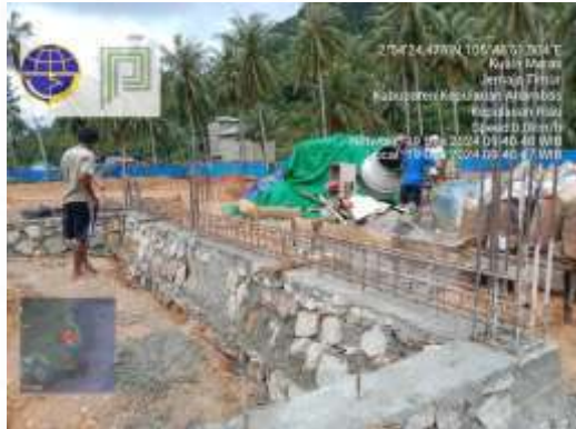
Pekerjaan gedung terminal
