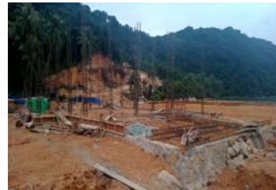
Pekerjaan gedung terminal
