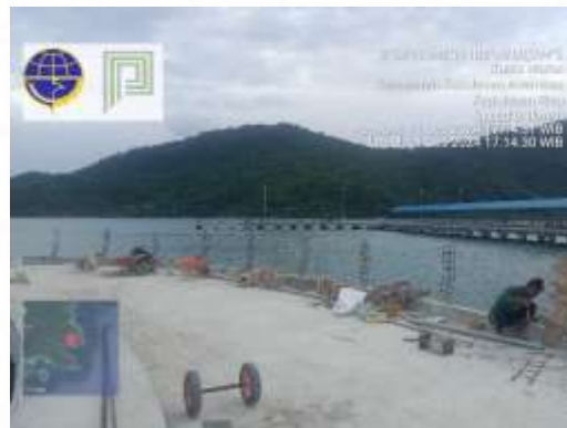
Pekerjaan Ralling pagar
