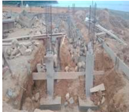
Pekerjaan gedung terminal
