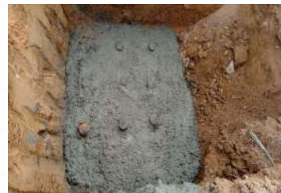
Pekerjaan gedung terminal
