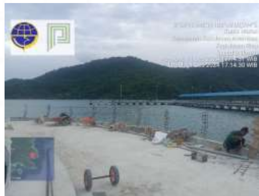
Pekerjaan Ralling pagar
