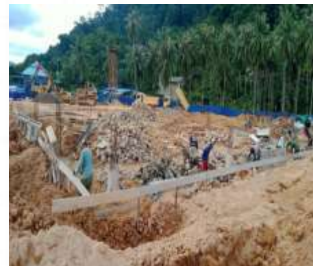
Pekerjaan gedung terminal
