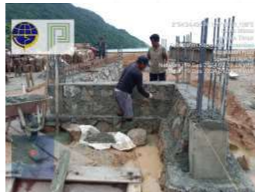
Pekerjaan Gedung Terminal
