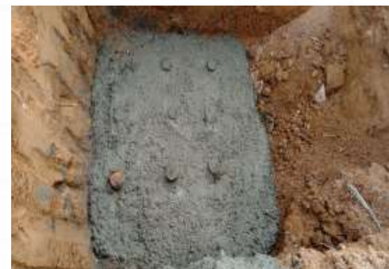
Pekerjaan gedung terminal
