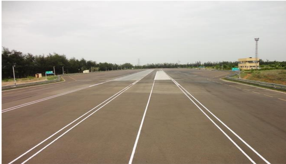
Gambar. 7 Fasilitas track pengujian ABS di ARAI India
